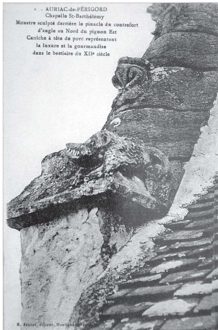
Au-dessus le rampant proprement dit est formé de chaque côté de dix larges dalles de pierre taillée qui débordent du mur et le protègent de l'eau. Une dalle sur deux porte un crochet orné de feuillage. Au sommet du pignon s'érige un fleuron à tige carrée, surmonté d'un bouquet à quatre branches qui est peut-être une allusion aux lys des armes de Souveraine d'Aubusson.
